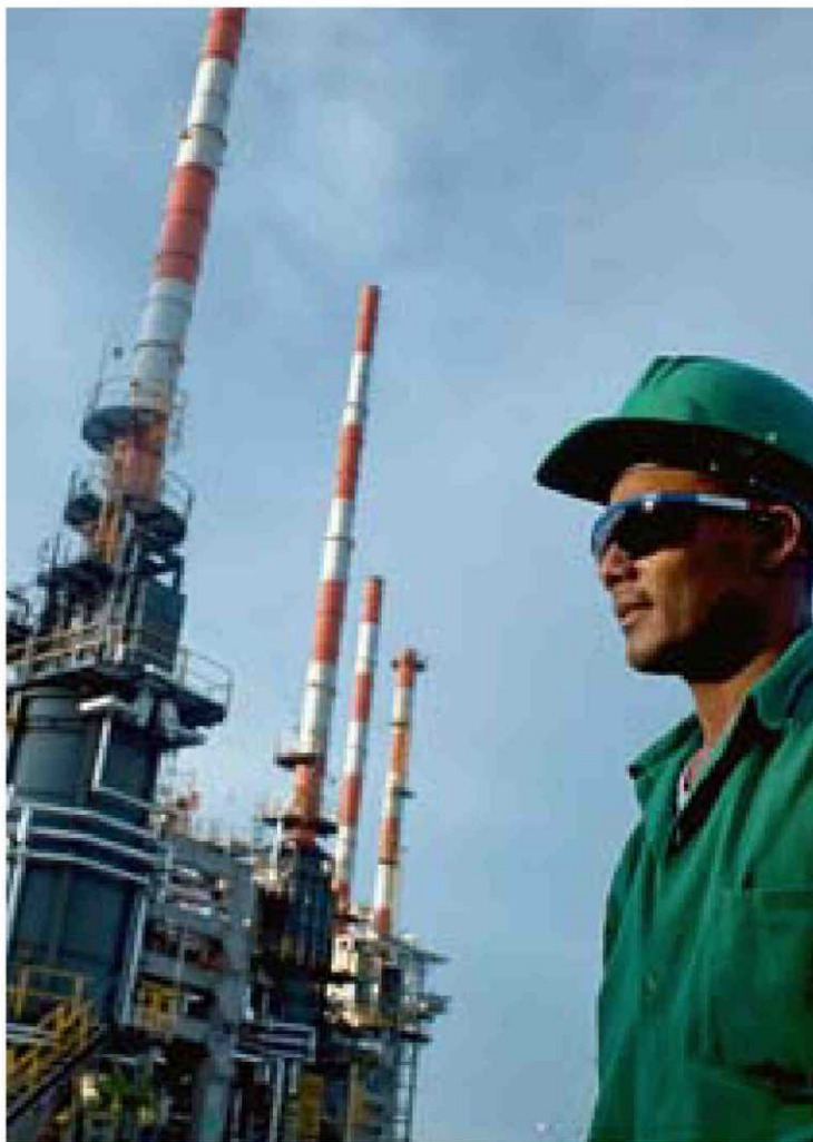
Un operario colombiano frente a unas instalaciones de Ecopetrol. BLOOMBERG
